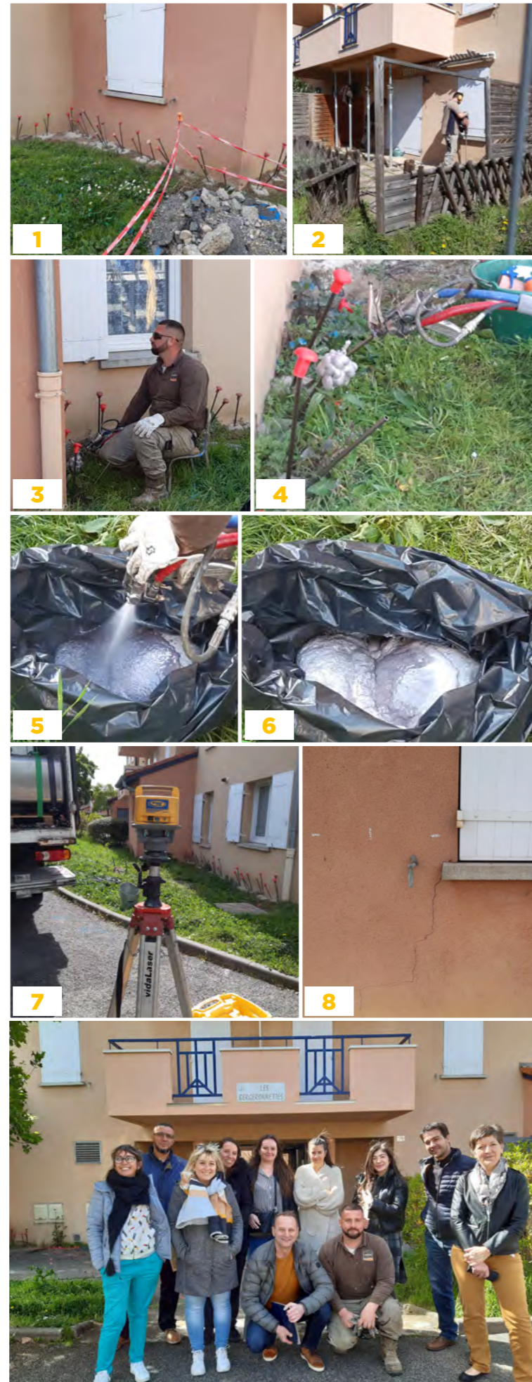
L'équipe Réhabilitation de la SEMCODA en visite de chantier
